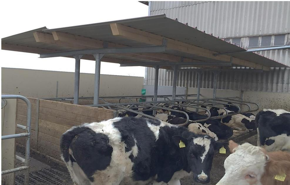
Axe fourragère, incl. poteaux, poutres de toit et tôle trapézoïdale sandwich.
